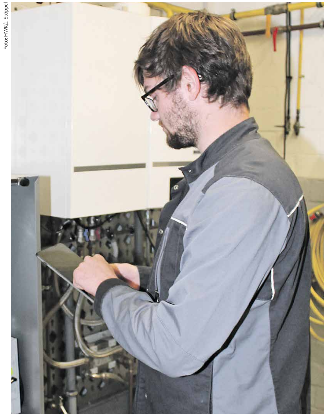
Mobile Endgeräte sind in vielen Handwerksbetrieben mittlerweile vollständig in den Arbeitsalltag integriert.
