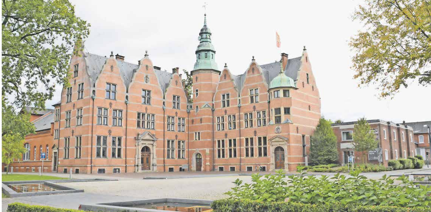
Das Landschaftshaus in Aurich ist Sitz der Ostfriesischen Landschaft. Der winkelförmige Bau mit Eckturm und dichtgereihten Zwerchgiebeln entstand in den Jahren 1898 bis 1901 im Stil der Neorenaissance. Vorbilder für den Architekten Hermann Schaedler aus Hannover waren Bauten der niederländische Renaissance.
