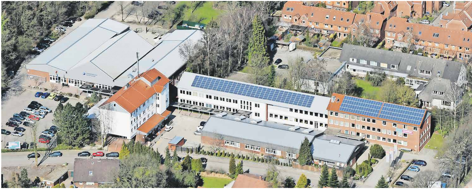
Investitionen geplant: Damit die Verwaltung der Handwerkskammer für Ostfriesland und die Lehrgangsräume und Werkstätten des Berufsbildungszentrums auch in den kommenden Jahren allen Anforderungen der Betriebe und ihrer Mitarbeiter genügen, wurden in der mittelfristigen Finanzplanung der Kammer erhebliche Mittel bereitgestellt.
