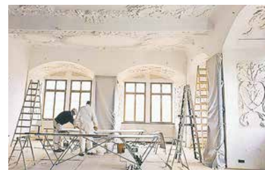
Restaurierungsarbeiten im Schloss.
